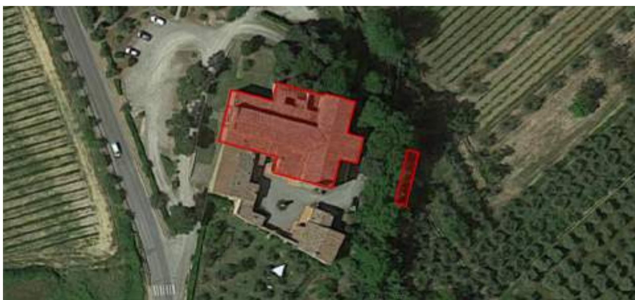
Vista aerea con individuazione dei corpi edilizi e delle aree che necessitano di intervento
